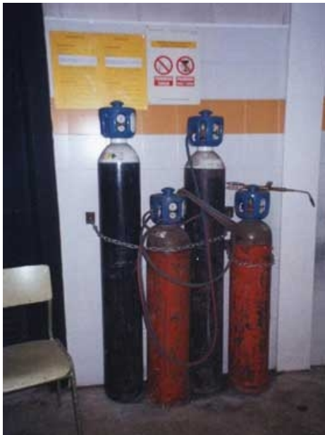
Figura 4. Equipo de soldadura autógena
