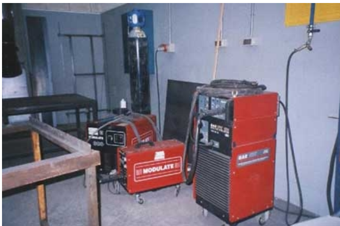
Figura 1. Grupos de soldadura eléctrica por arco tipo MIG
